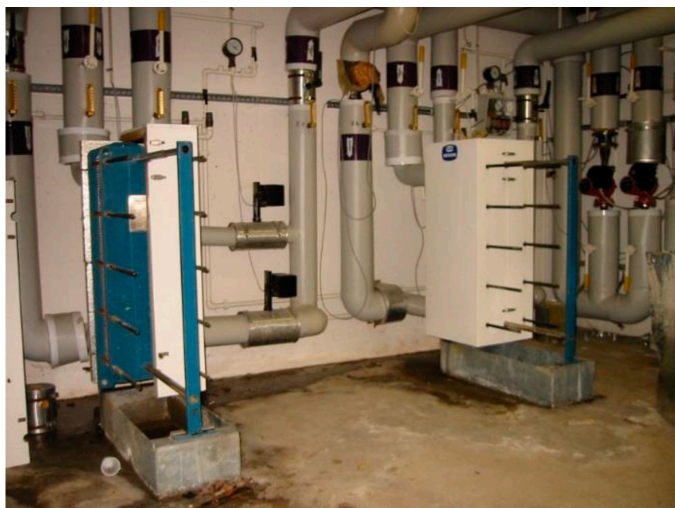
Figur 3. Indirekte anlæg med veksler i etagebolig
