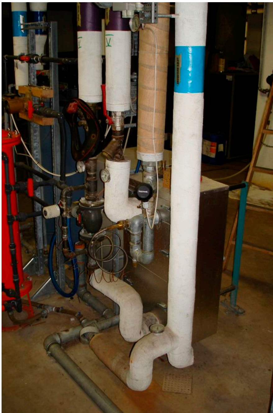
Figur 2. Isolering af rør til varmt brugsvand
