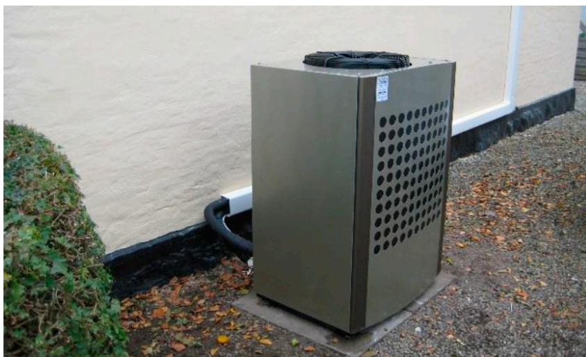
Luft-vandvarmepumpe (udedel)
