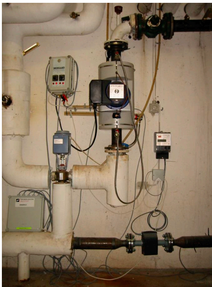
Figur 3. Præfabrikeret isoleringskappe på cirkulationspumpe
