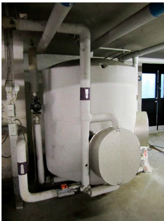
Figur 4. Isolering af varmtvandsbeholder
