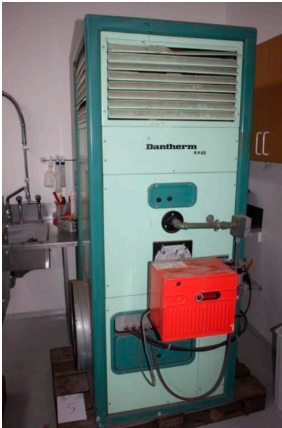
Figur 9. Gasfyret kalorifere
